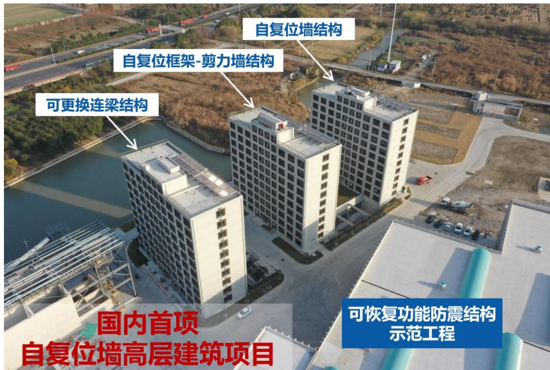
图 8 可恢复功能高层结构示范工程
